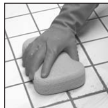
2. Laissez le coulis sécher de 10 à 20 minutes, puis nettoyez les carreaux et les joints avec une éponge humide.
