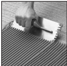
1. Étalez le mortier sur la surface à l'aide d'une truelle dentelée, que vous tiendrez à un angle de 45°.
