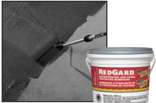
Appliquez la membrane RedGard® à l'aide d'un rouleau.
