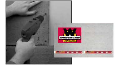
Installez une planche d'appui WonderBoard de 13 mm (1/2 po).
