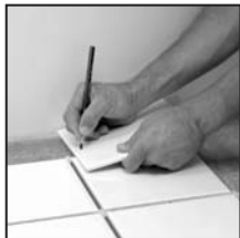
Après avoir disposé tous les carreaux, déterminez ceux qui devront être coupés. Indiquez les endroits où couper avec un crayon gras ou un marqueur.
