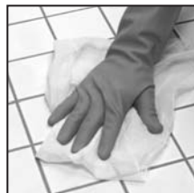
3. Une fois que le coulis est sec, enlevez les résidus de coulis à l'aide d'un chiffon de toile à fromage sec. Laissez le coulis durcir de 48 à 72 heures avant d'appliquer le scellant.
