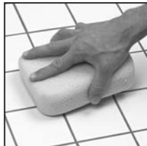
4. Nettoyez les résidus de mortier présents entre les carreaux, ou sur ceux-ci, à l'aide d'une éponge et d'un tampon à recurer.
