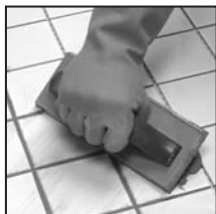
1. Après avoir posé les carreaux, attendez 24 heures avant de remplir les joints avec le coulis. Étendez le coulis Polyblend® dans les joints à l'aide d'un aplanisseur à coulis que vous inclinerez à 45° et sur lequel vous appuyerez avec force.
