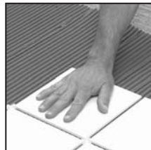
2. Scellez solidement les carreaux en les faisant légèrement bouger.
